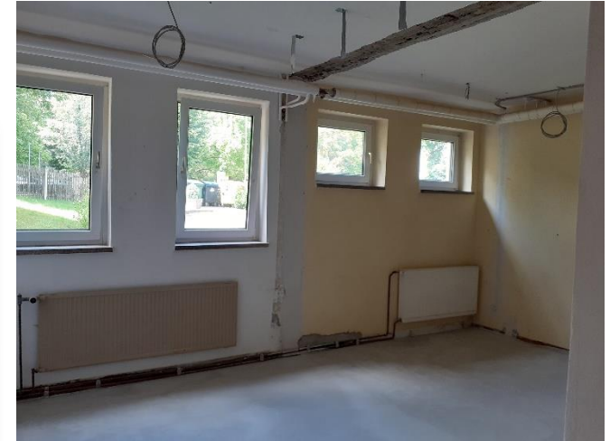
Der alte Fußboden ist schon rausgemacht, nun muss die Ausgleichsmasse trocknen...
