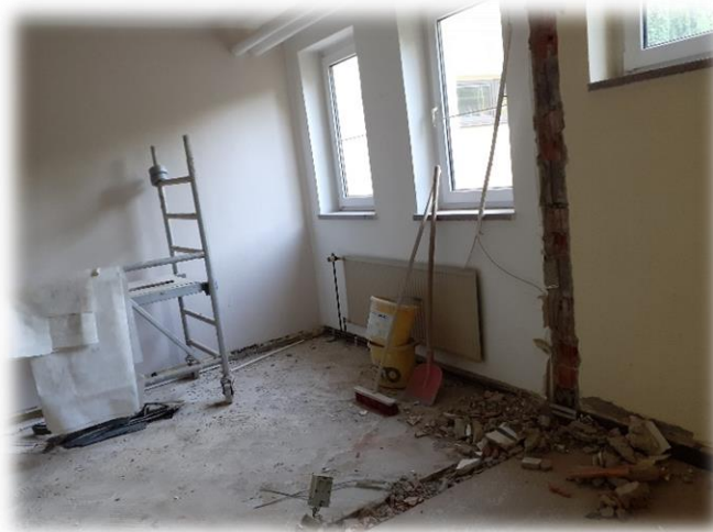
Der alte Fußboden ist schon rausgemacht, nun muss die Ausgleichsmasse trocknen...
