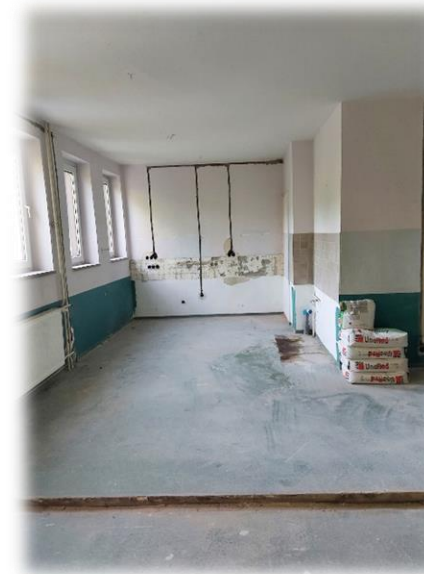
Der alte Fußboden ist schon rausgemacht, nun muss die Ausgleichsmasse trocknen...
